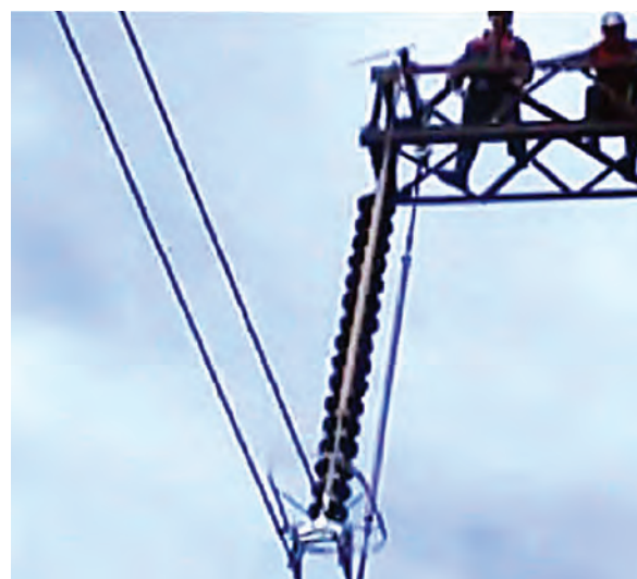
Проведение работ на ВЛ с помощью балки и подхвата
