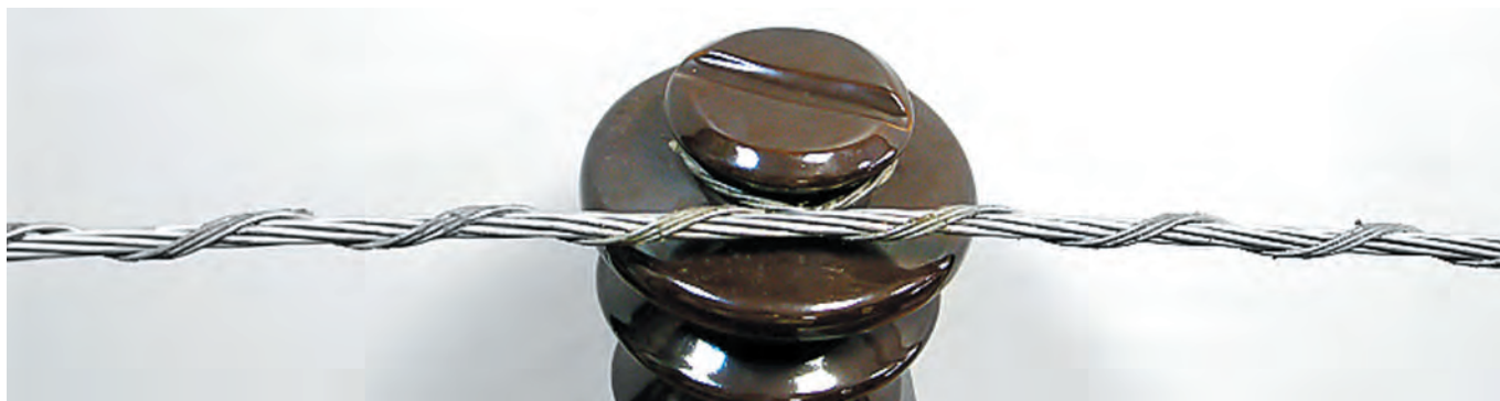
Рисунок 2 - Крепление провода AC 95/16 с применением одиночной вязки BC-13,5/14,0-85-12 на штыревом изоляторе.
