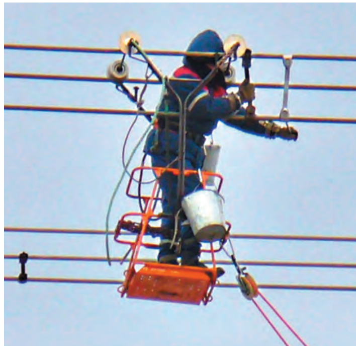
Тележка для передвижения по проводам расщепленной фазы
